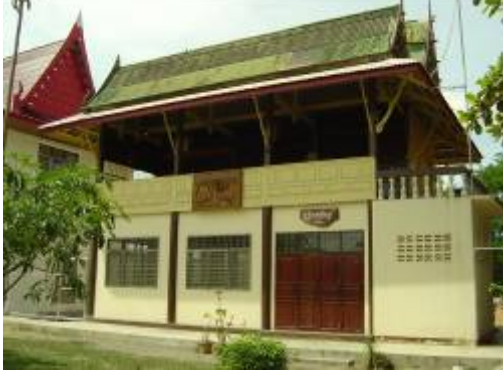
ซ่อมแซมกุฏิสงฆ์ทรงไทยยกสูงเป็นสองชั้น ๑ หลัง
