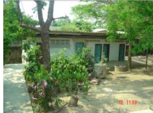
ซ่อมแซมห้องน้ำและห้องสุขา
