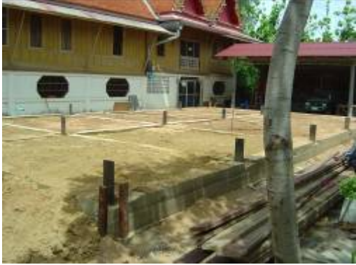
รูปภาพชุดที่ ๖ โครงการสร้างหอฉัน-โรงครัว หอฉัน
