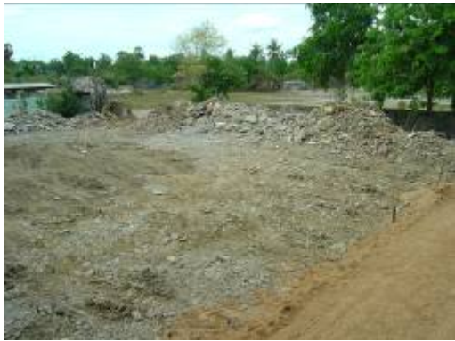
รูปภาพชุดที่ ๗ โครงการสร้างอาคารคหพันธ์ (๒ ชั้น ๑๖ ห้อง)
